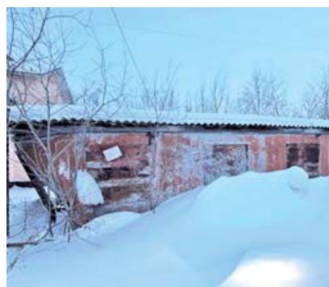
Металлический балок (реестровый номер: объект №418)
