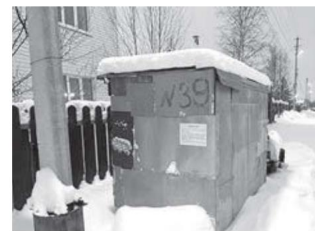
Металлический сарай (реестровый номер: объект №435)
