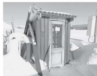
Металлическая будка размещена рядом с гаражами в северной части промышленной зоны в районе бывшей базы УНГГ (реестровый номер: объект №44)
