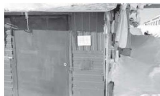
Металлический бункер размещён возле гаража в северной части промышленной зоны в районе бывшей базы УНГГ (реестровый номер: объект №49)
