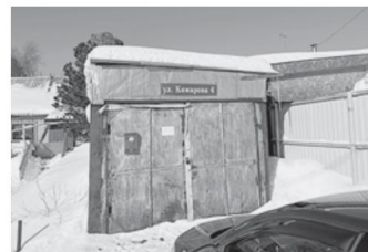
Металлический бункер расположен возле жилого дома №4 по ул.Комарова (реестровый номер: объект №43)
