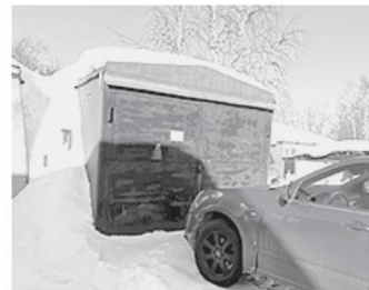
Металлический бункер расположен возле жилых домов №№9-10 по ул.Таёжной (реестровый номер: объект №42)
