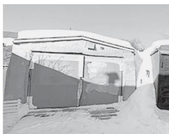
Металлический бункер расположен возле жилых домов №№9-10 по ул.Таёжной (реестровый номер: объект №41)
